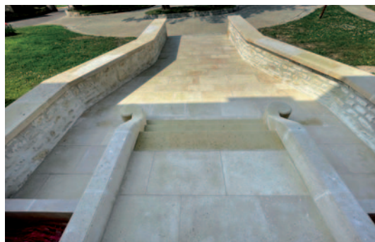
Avant/après, rénovation des murets, des escaliers et du dallage de l'entrée de l'Hôtel de Ville de Moyvillers (60). Toutes les pierres ont été façonnées dans les ateliers de Saint-Pierre-Aigle avec montage à sec pour visualiser le rendu final.
