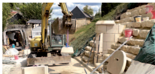
Travaux de réfection d'un puits avec pierre d'enrochement de soutènement d'un talus à Béthancourt-en-Valois. Il s'agit d'une reconstitution à l'identique de cette pièce, réalisée en pierre demi-dure de la Croix-Huyart. Exemple type de la synergie des trois entités familiales : pierre de la carrière de Benoît, façonnage dans les ateliers de Gautier et pose par Fabien Horcholle.
